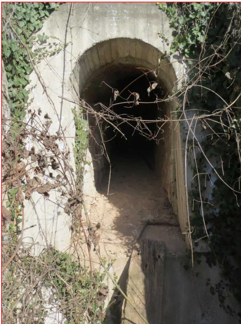
Vstup do zasypanej chodbičky vodovodu nad Žižkovou ulicou.
