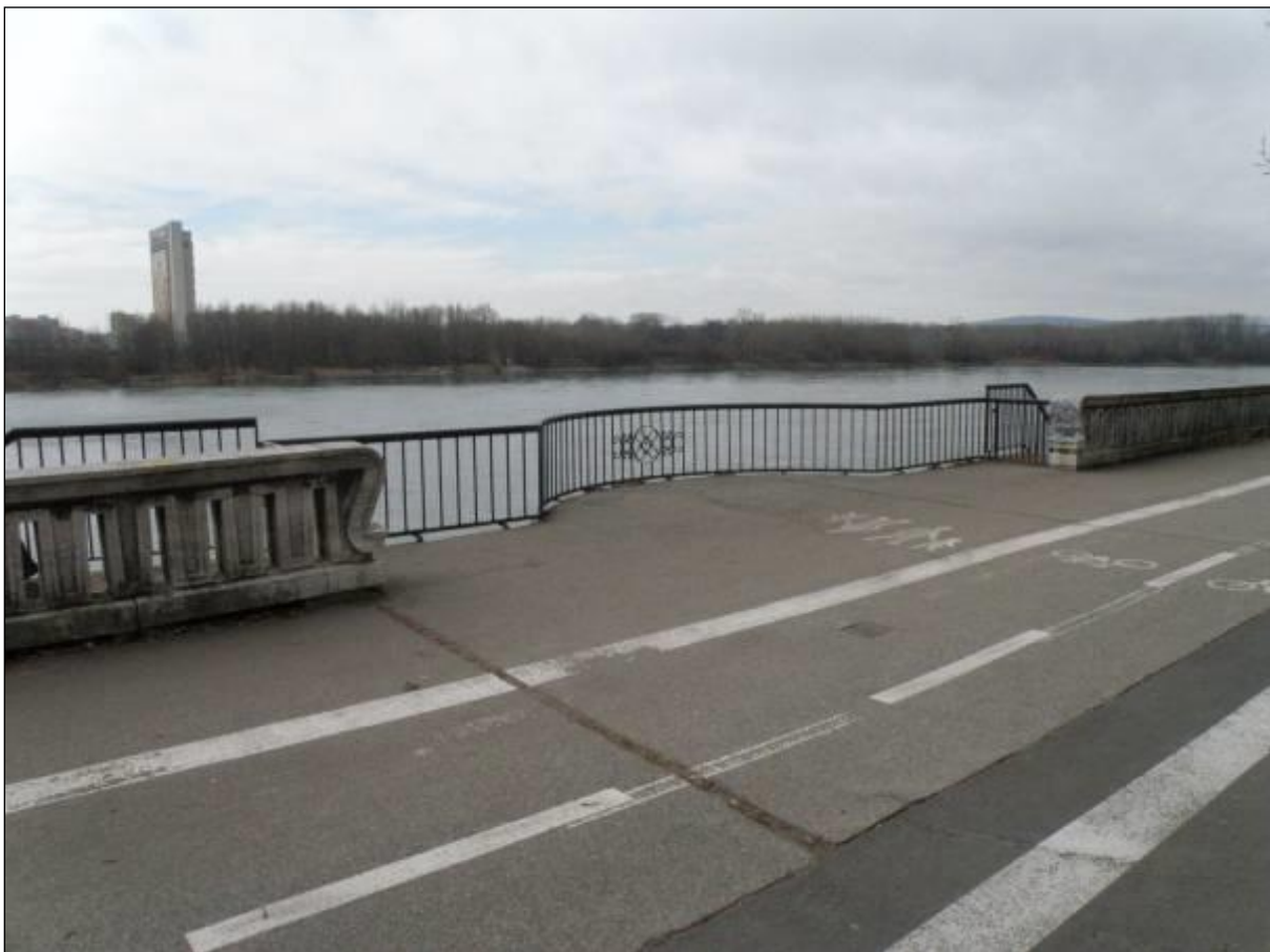
Vysunutá vyhlídková terasa s kovovým zábradlím
