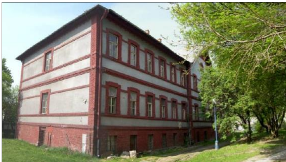
Objekt kasární pre železničný personál z konca 19.stor.
