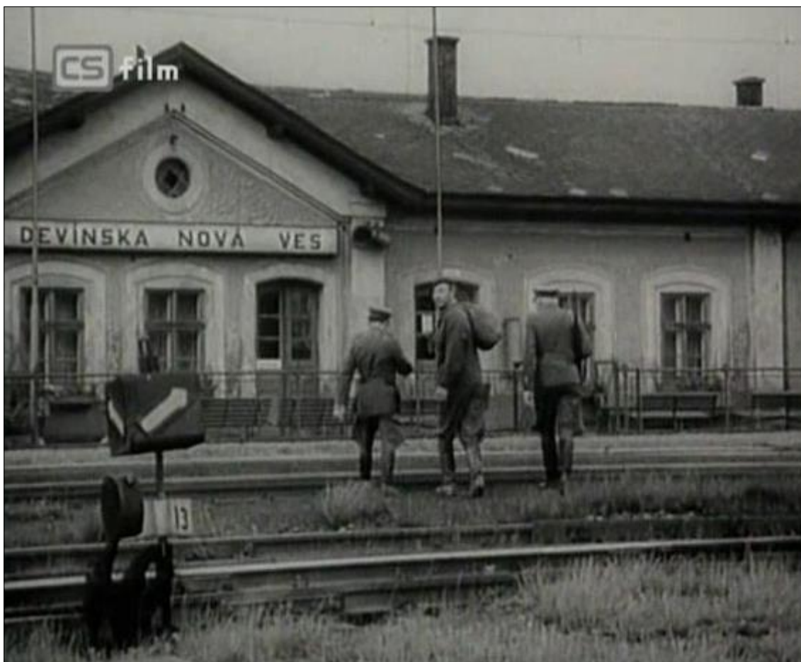
Pôvodná staničná budova (1848 – 1980)
