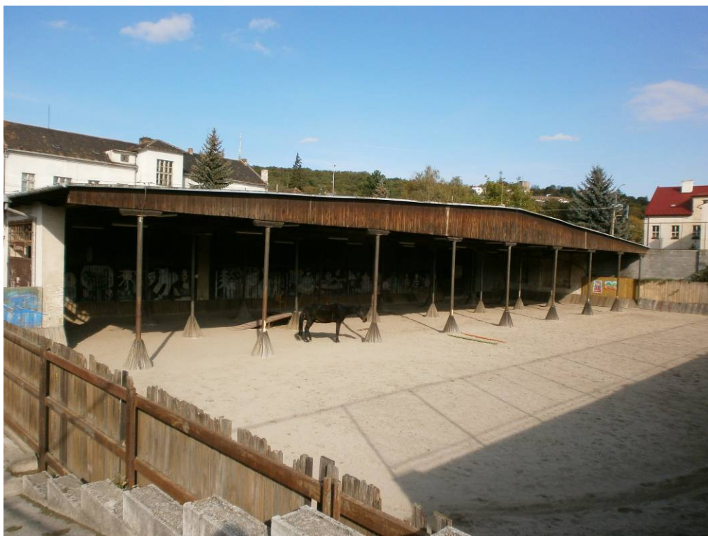
Časť pôvodnej výrobnjej haly po odbúrání.
