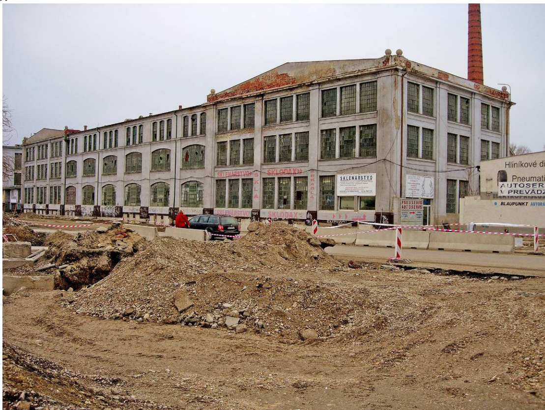
Pohľad z Košickej ul.- počas výstavby mosta Apollo
