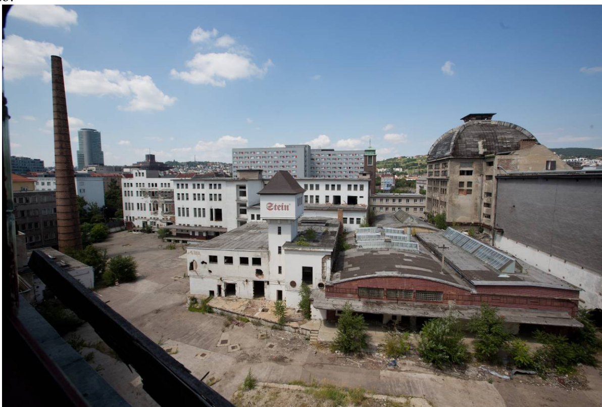
Pohľad na areál z východu pred jeho demoláciou (vpravo vzadu objekt „spilky“)
