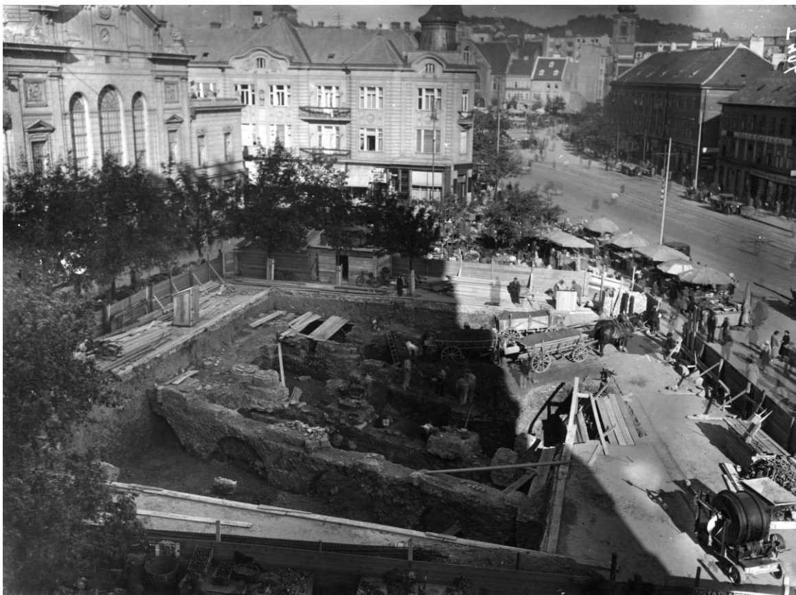
Odhalenie základov kostola v roku 1935
