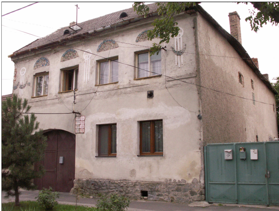
Pôvodný stav fasády v roku 2006
